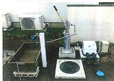
井戸設備工事
