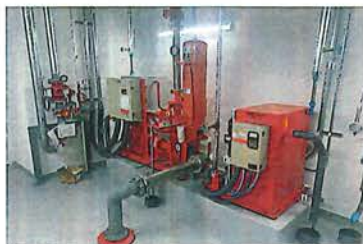
消火設備工事
