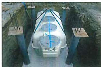
浄化槽設置工事
