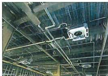
空調設備工事
