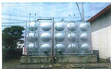
受水槽設備工事
