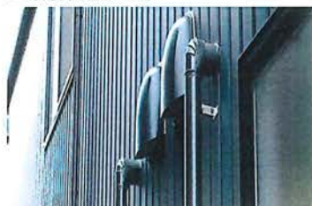
換気設備工事
