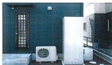
給湯設備工事
