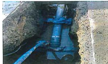
下水道設備工事
