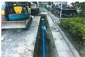
給水管（配水管）敷設工事
