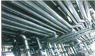
プラント配管設備工事
